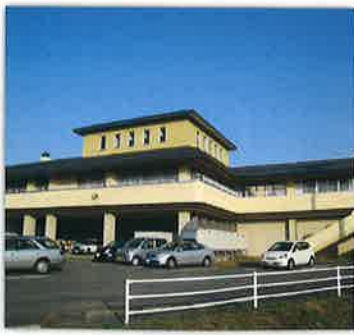
1999年10月 新棟増設
