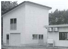
大型倉庫設置
